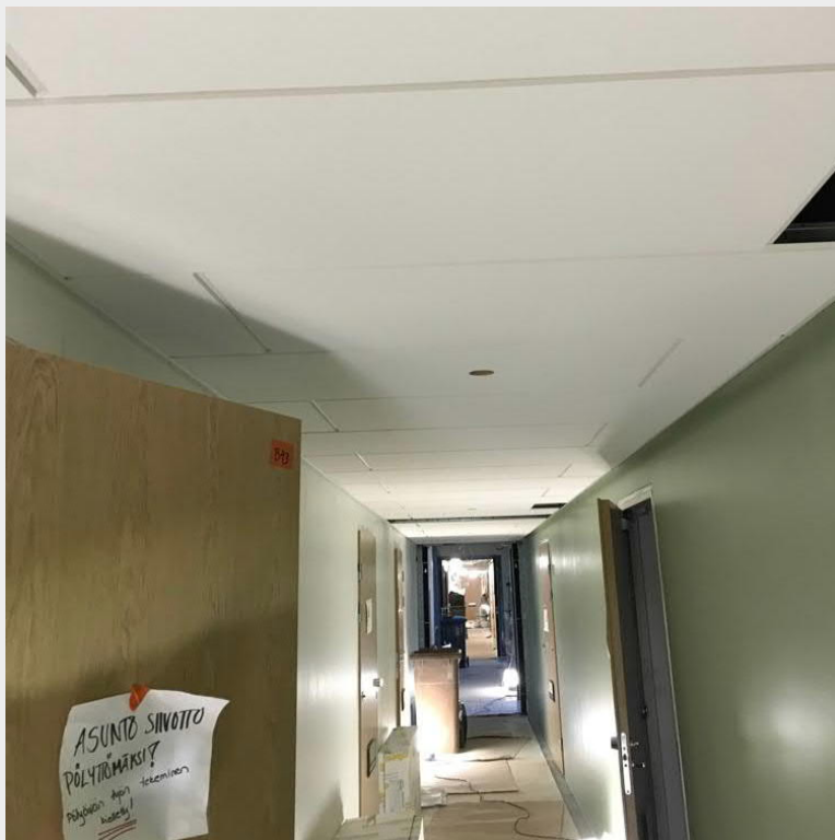
Alakatto asennettuna porrashuoneessa (kuva 22.2.2019).
