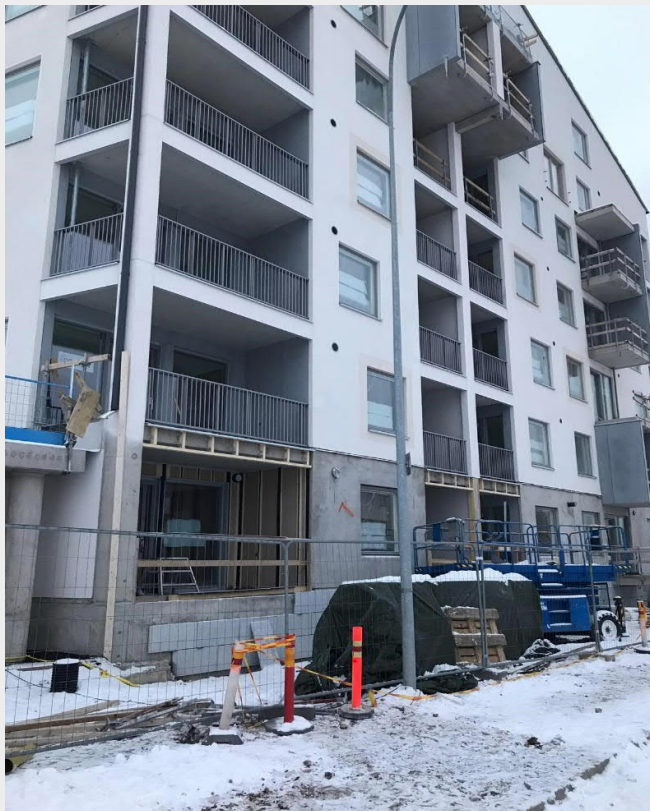
Kadun puolella asennettuna ensimmäisiä parvekekaiteita (kuva 30.11.2018).
