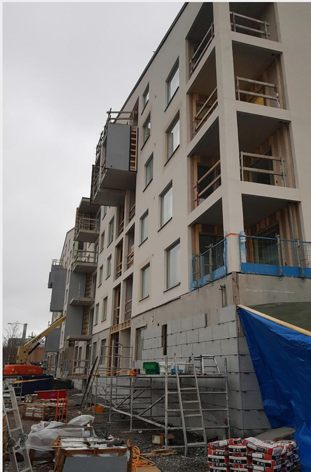
Luonnonkiviverhoilu ja julkisivulevytyksiä kadun puolella (kuva 12.12.2018)
