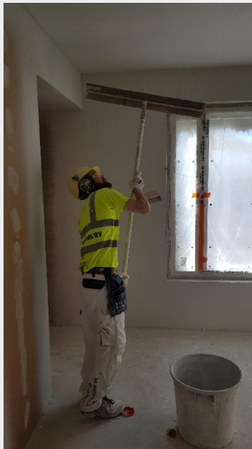
Vasemmalla tasoitettöitä, oikealla kylpyhuoneen laatoituksia.
