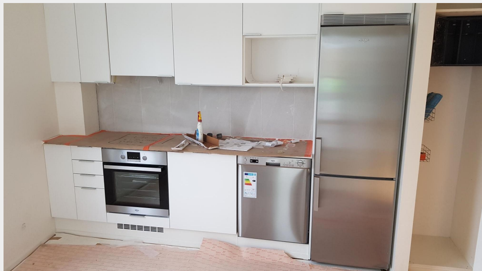
Kodinkoneita asennettuna mallihuoneistoon (kuva 12.10.2018).
