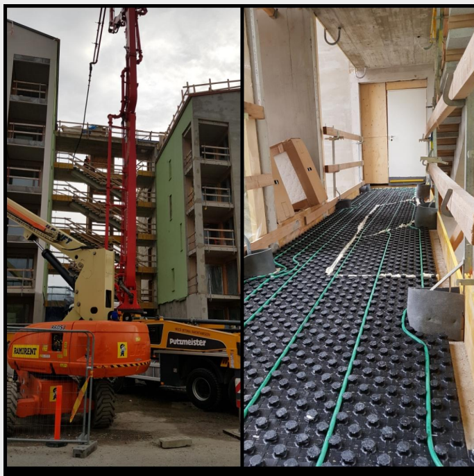
Talojen yhteisen porrashuoneen pintalattiat ovat valussa tänään (kuva 8.10.2018).
