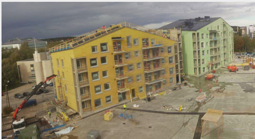
Yleisnäkymä työmaalle (työmaakamerakuva 28.9.2018).
