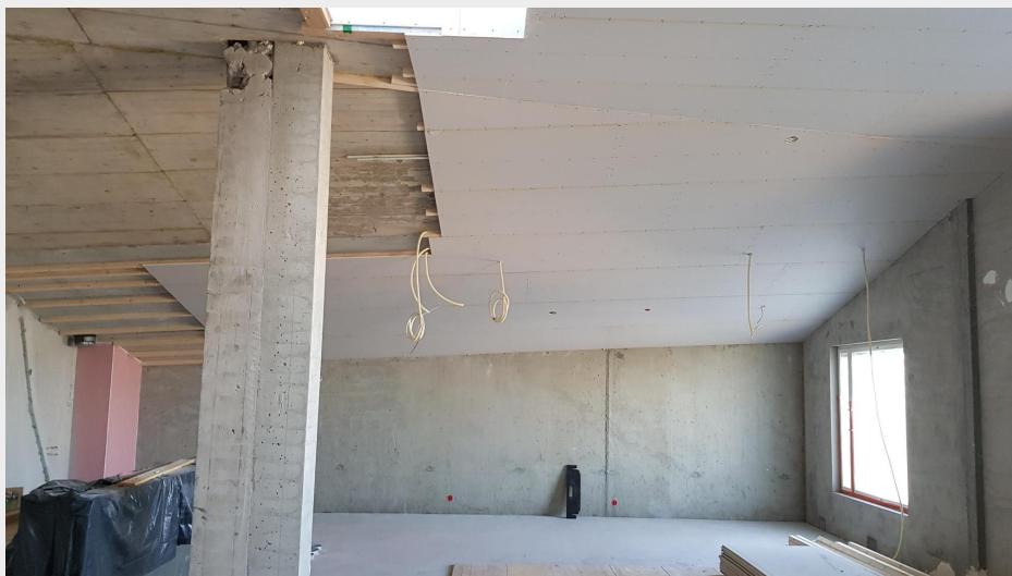
Ylimmän, kaksikerroksisen huoneiston koolaus –ja levytystöitä / 7. krs katto.
