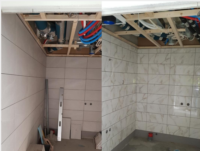
Kahden mallihuoneiston kylpyhuoneseinälaatat asennettuna.
