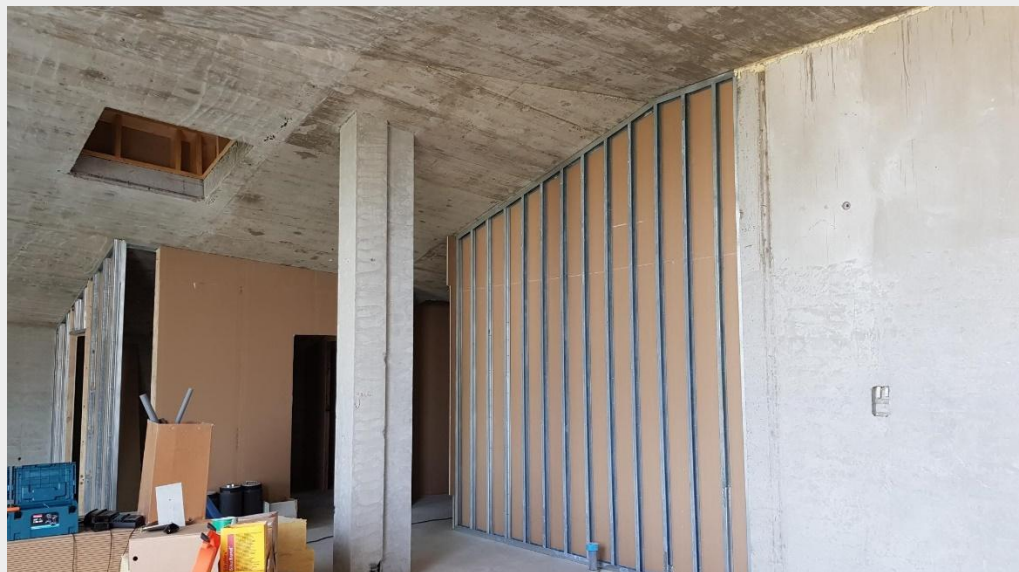
C-talon 6. kerroksen huoneiston korkeaa kipsilevyseinää työn alla. Kuvassa näkyy myös asunnon kattoikkuna-aukko. (Kuva 6.9.2018)
