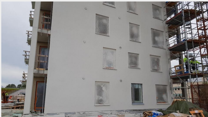
B-talon pohjoispuolen päädyn rappaus on nyt valmis (kuva 27.8.2018).
