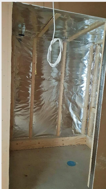
Saunojen puu-/koolaustöitä ja eristyksiä tehtynä B-talossa. Koolaustöiden jälkeen tehtävät panelointityöt starttaavat lähiviikkoina (kuva 13.8.2018)
