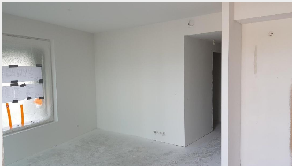
B-talon huoneiston seinä- ja kattopintaa maalattuna. (kuva 13.8.2018)
