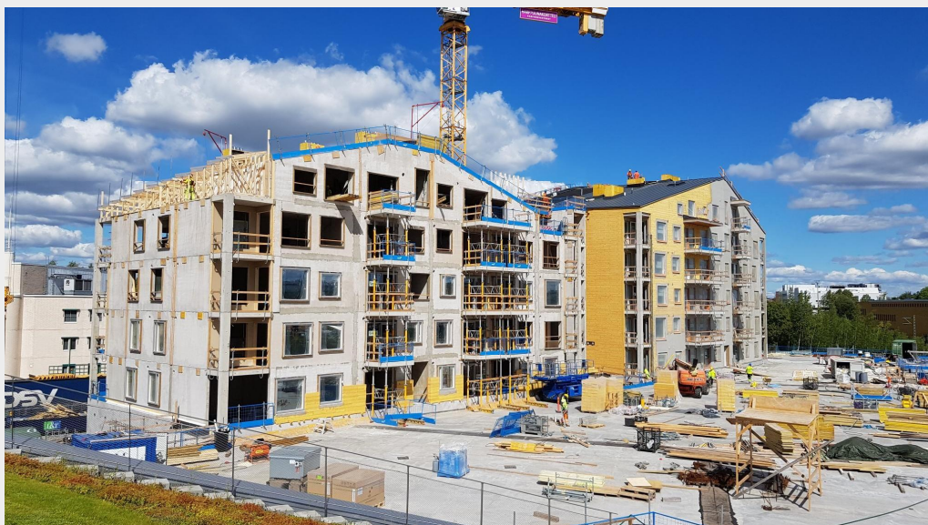
Yleisnäkymää työmaalle N-talon viherkatolta. (kuva 7.8.2018)
