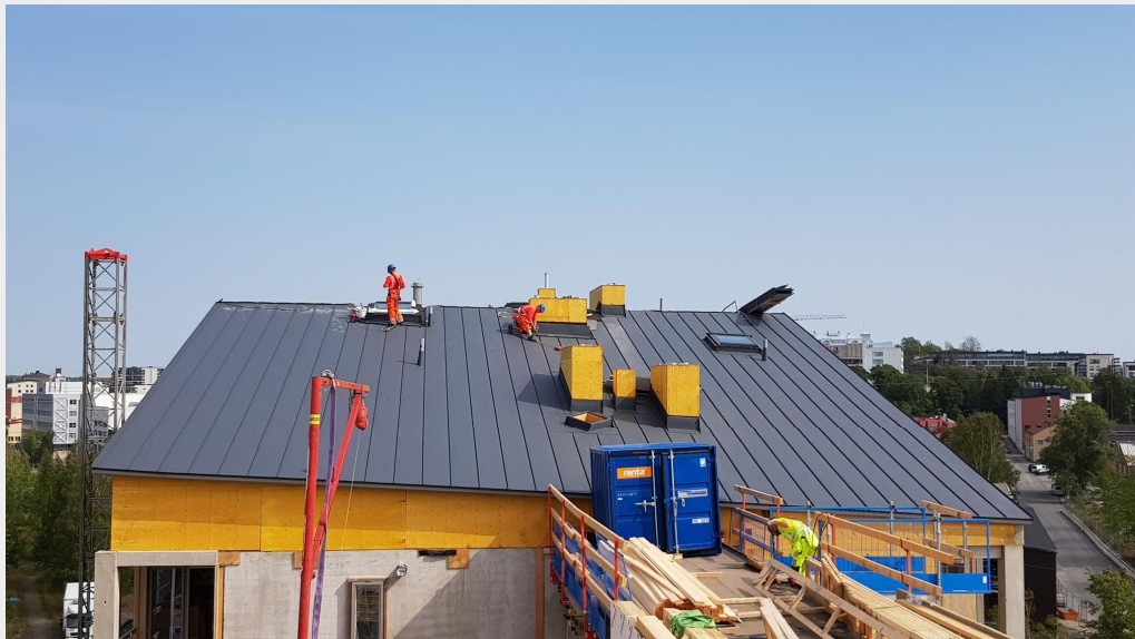
B-talossa vesikaton etelänpuoleinen lape on pellitetty hormeja lukuun ottamatta. (kuva 10.8.2018)
