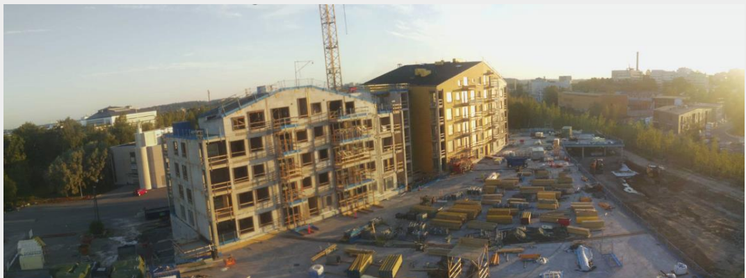
Betonirungot ylhäällä (kuva 18.7.2018)
