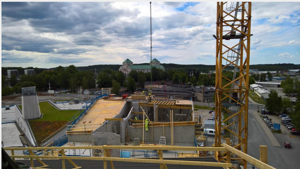
C-talon yläpohjan laudoitustyöt voitonpuolella. (kuva 11.7.2018)
