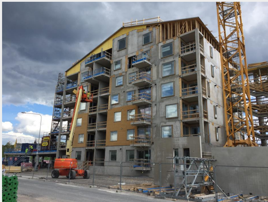
B-talon villoitustöitä ja katon reunan vanerointia ja räystäitä (kuva 9.7.2018)
