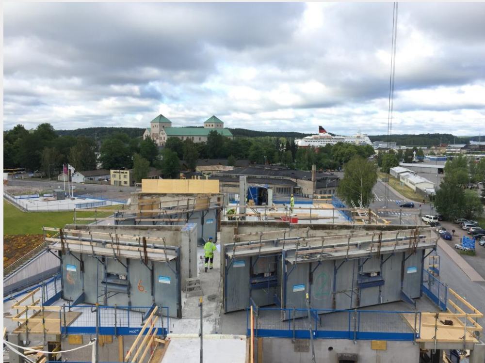
Suurelementtimuottien käyttöä. (5.7.2018)
