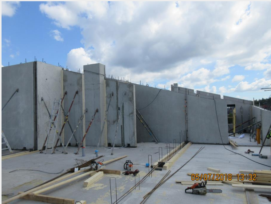
C-talon ylimmän kerroksen elementtiasennuksia. (kuva 5.7.2018)
