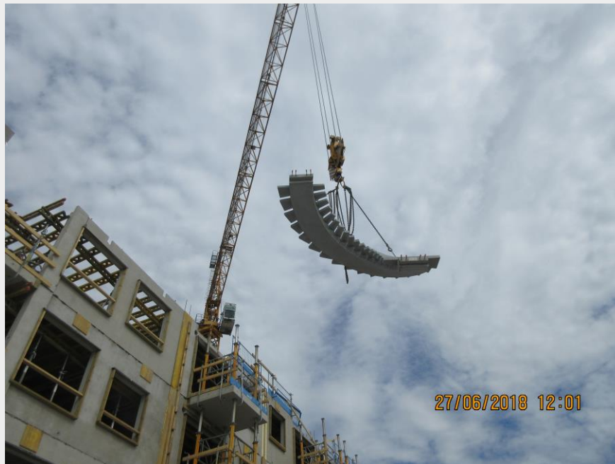
Porraselementtinosto kauniilla kesäsäällä. (27.6.2018)
