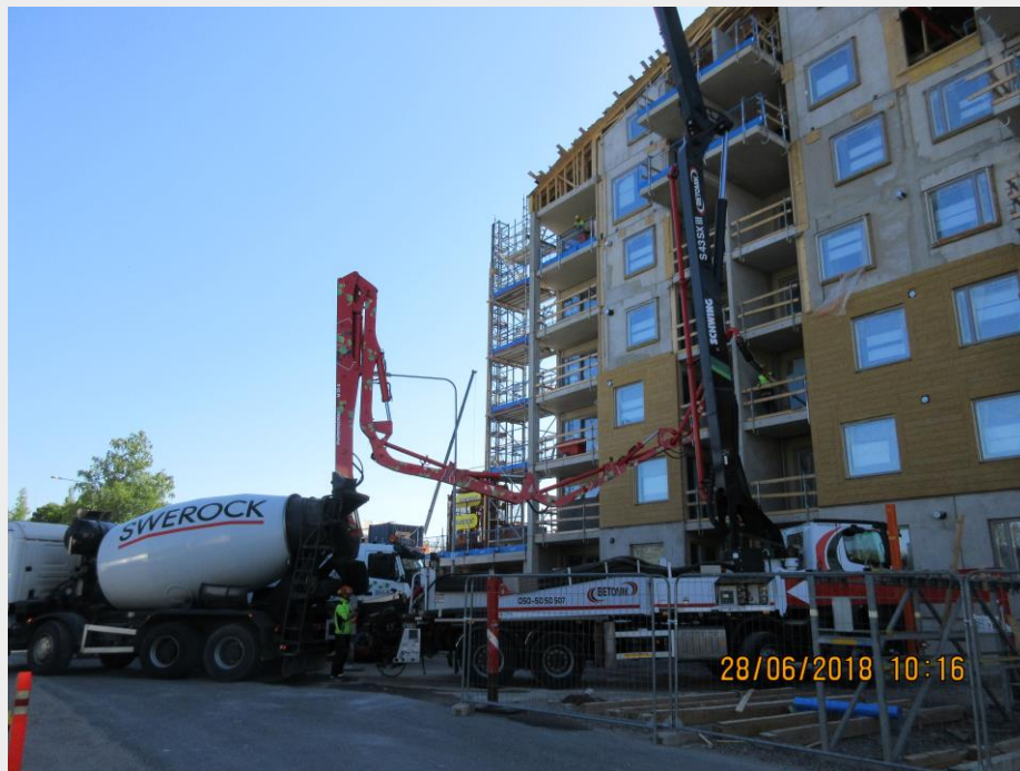
Kaksi betonipumppuautoa pintavaluille ja hormeille (kuva 28.6.2018).
