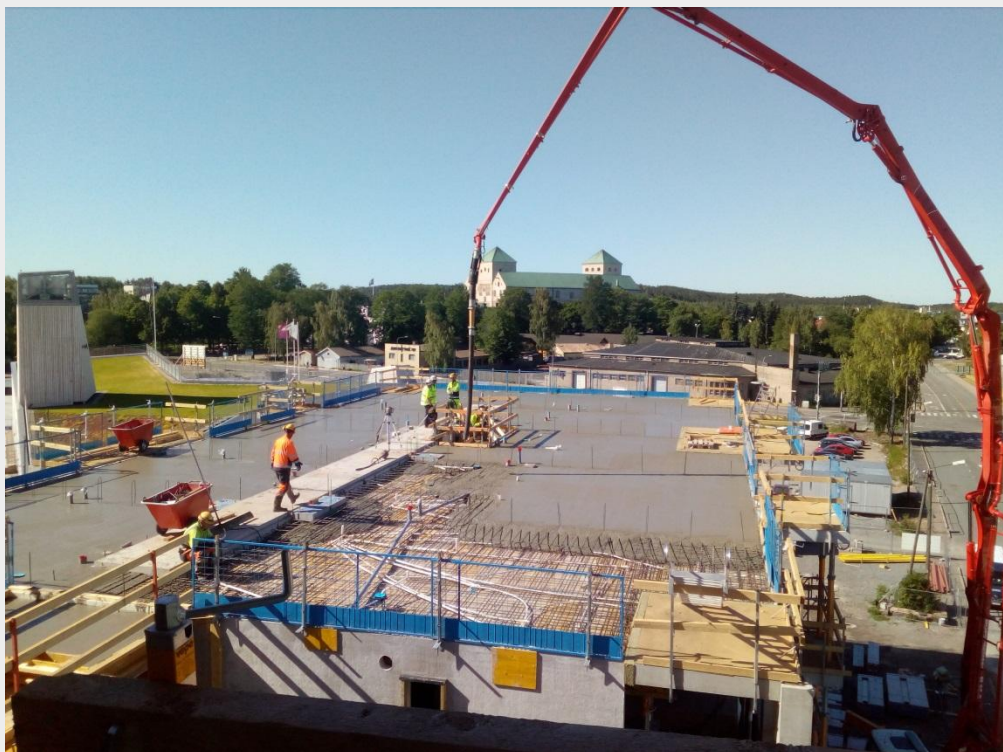
4. kerroksen holvin valutöitä (kuva 20.6.2018)
