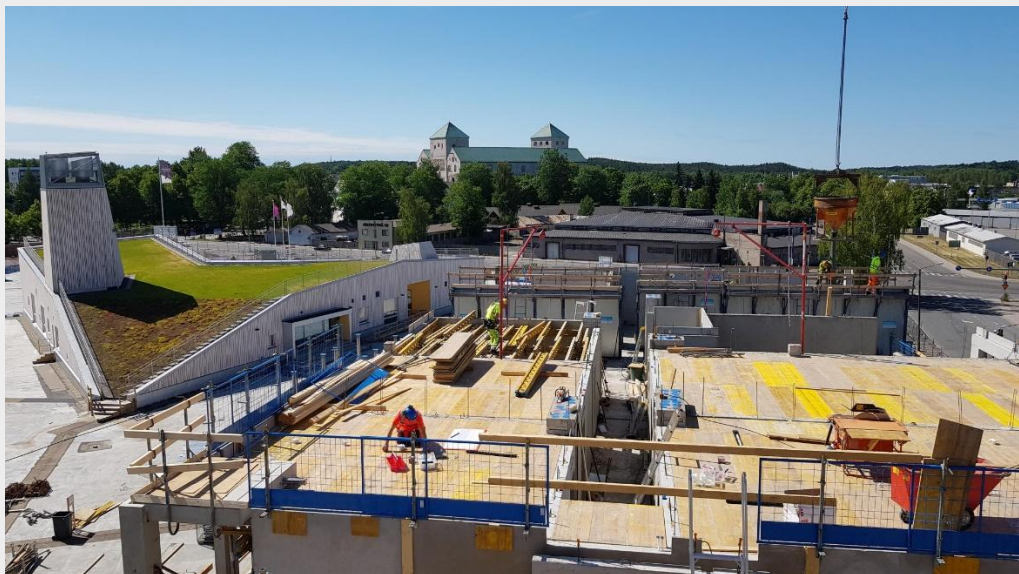
Holvin muottitöitä 4. krs:ssa (kuva 12.6.2018).
