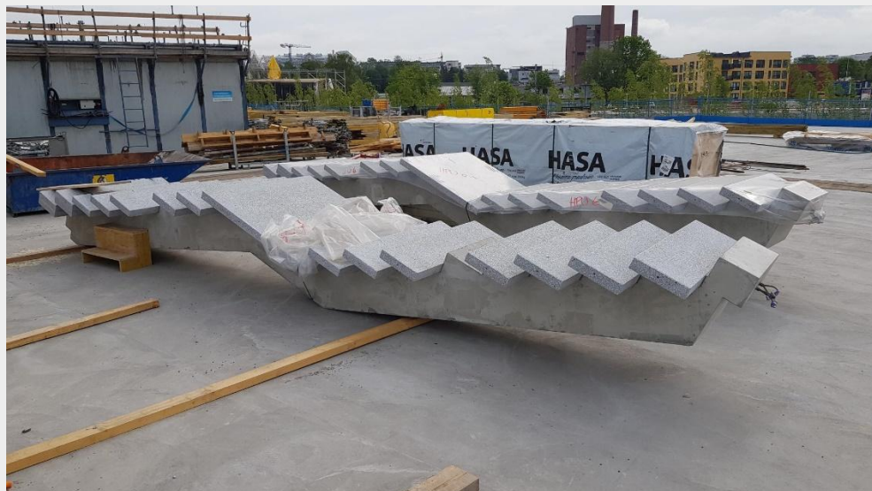
Talojen välisen porrashuoneen porraselementtejä odottamassa asennusta kansilaatan päällä.
