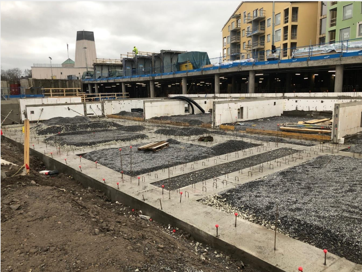
M-talon ontelolaataston alapuolen täyttötöyt käynnissä
