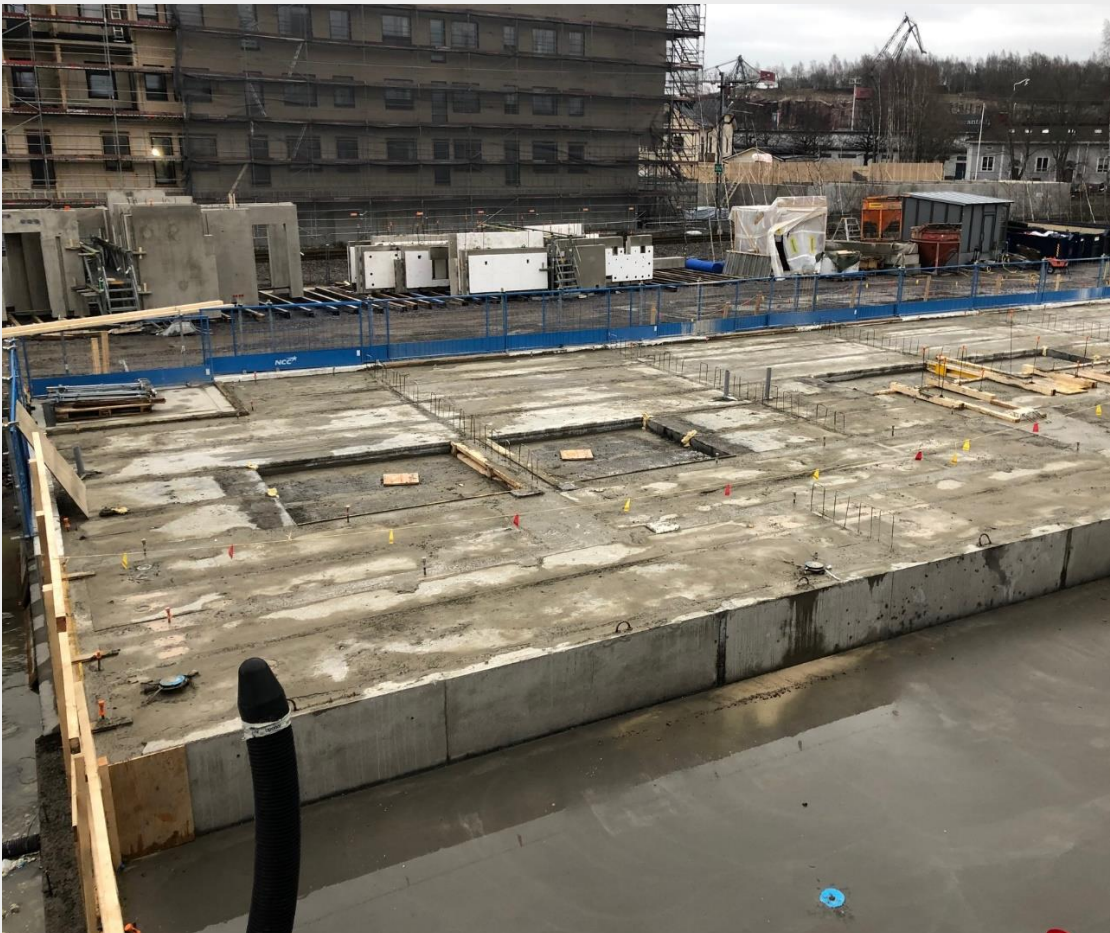
L-talon ontelolaatat asennettu ja ontelosaumat valettu
