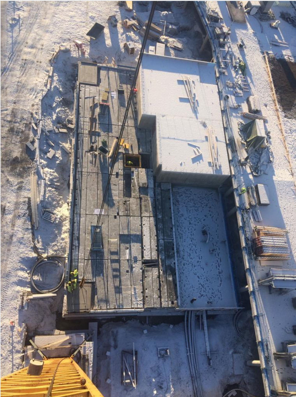
L-talon ontelolaatta-asennus käynnissä
