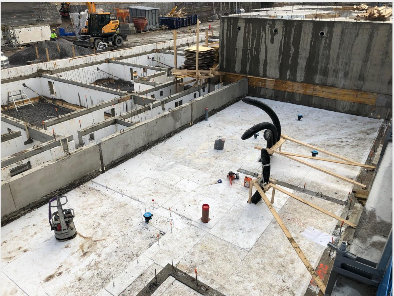
L-talon maanvaraisen alapohjan tekniikka ja eristeet asennettu
