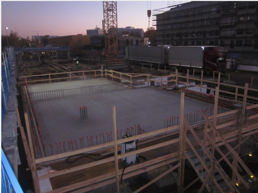
Väestönsuoja alapohja valettu
