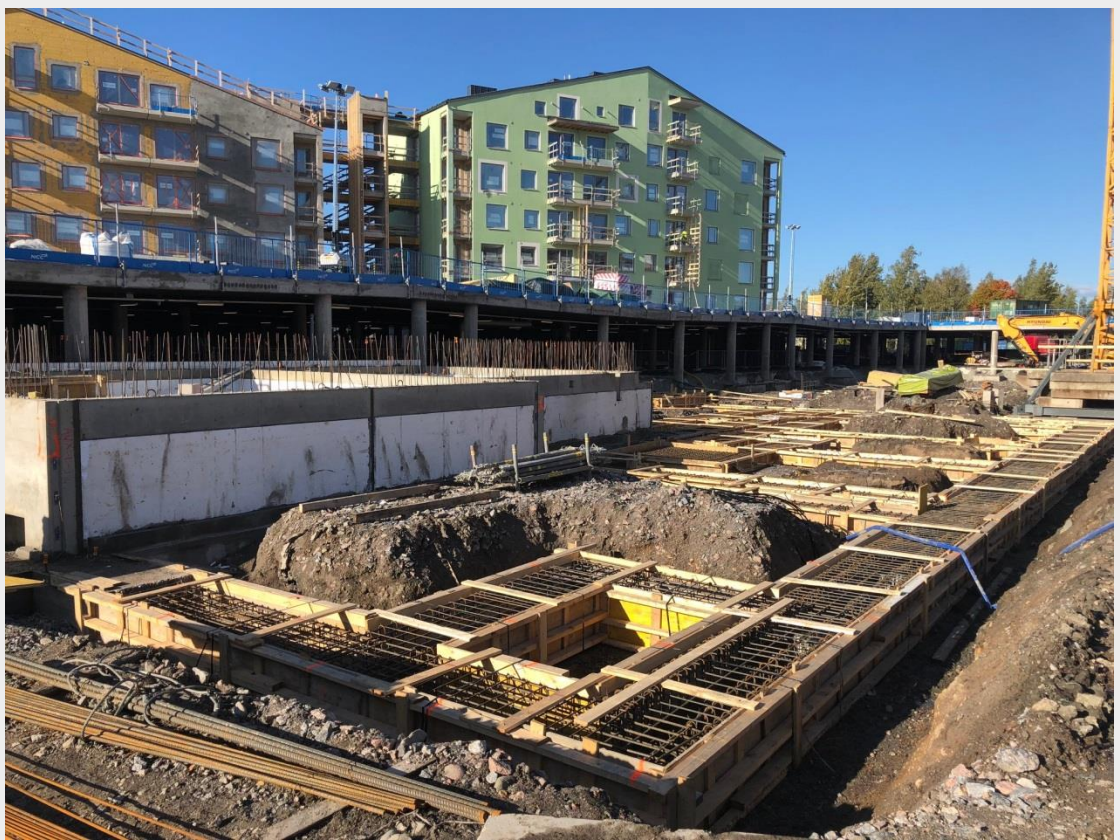
L-talon nauha-anturat laudoitettu ja raudoitettu
