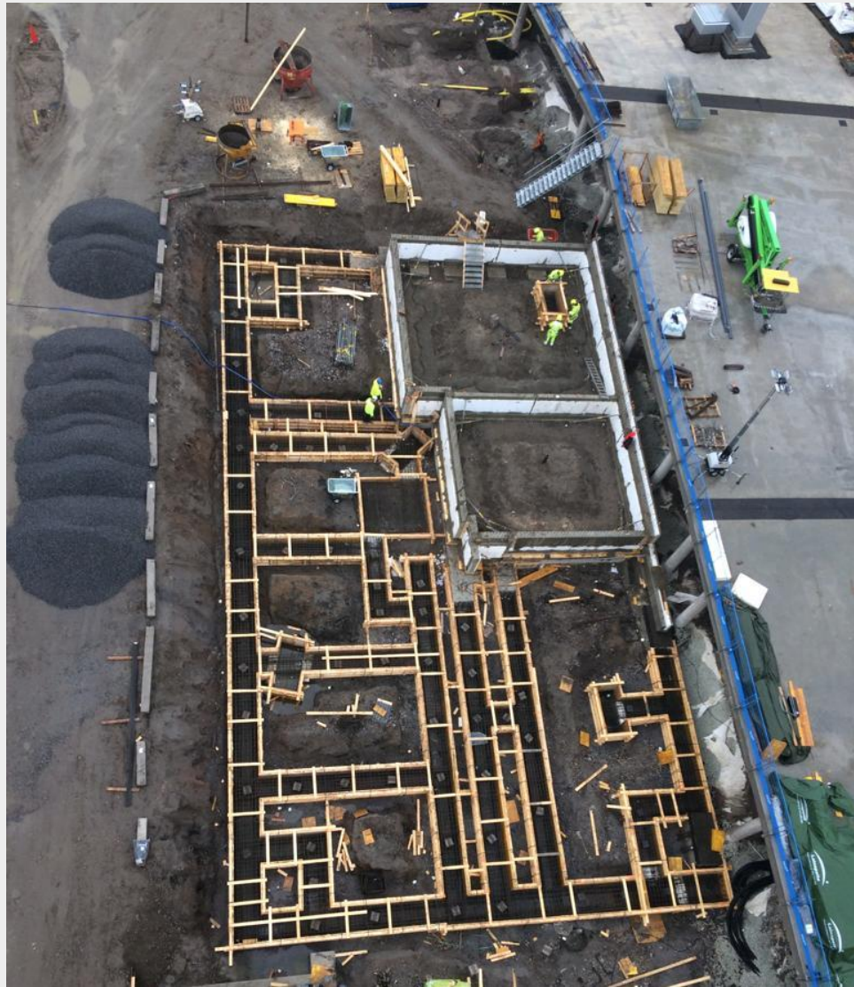
L-talon pohjan anturat laudoitettu ja raudoitettu sekä VSS-alueen sokkeliementit asennettu
