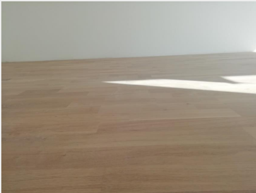
L-talon parkettiasennukset ovat aloitettu
