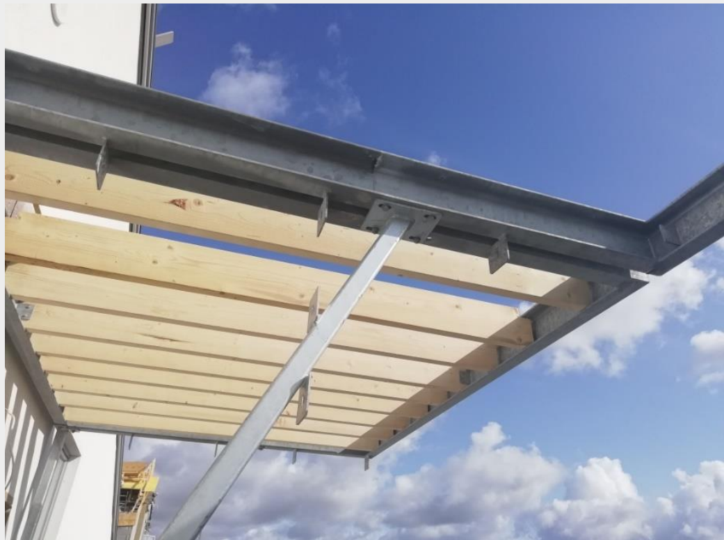
L-talon 6. kerroksen teräskatoksen runko
