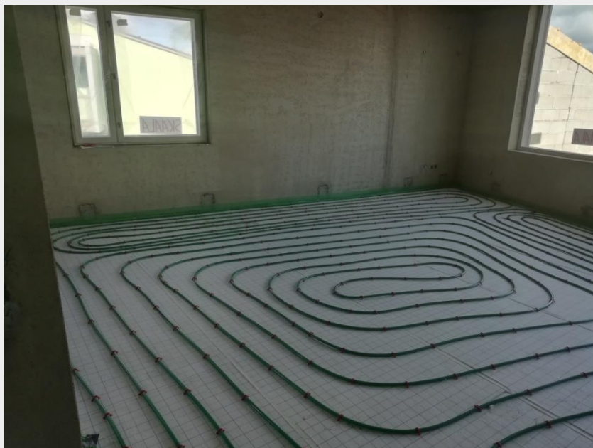
M-talon lattialämmitysputket ennen viimeistä pintalattiavalua
