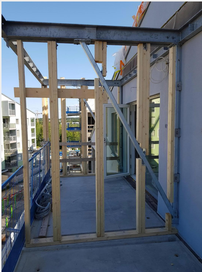
Parvekkeiden puu- ja levytyöt työn alla (kuva 19.6.2019).
