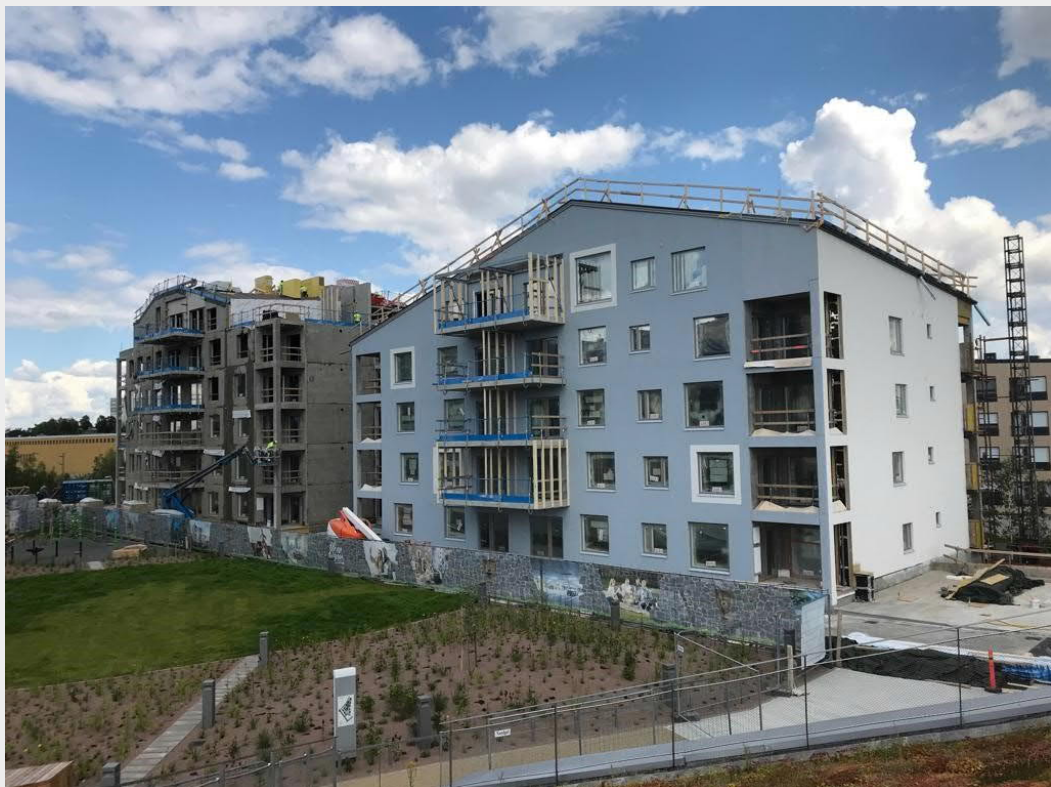
L-talon julkisivurappaus on valmistunut kannen puolen sekä eteläpäädyn osalta (kuva 18.6.2019).
