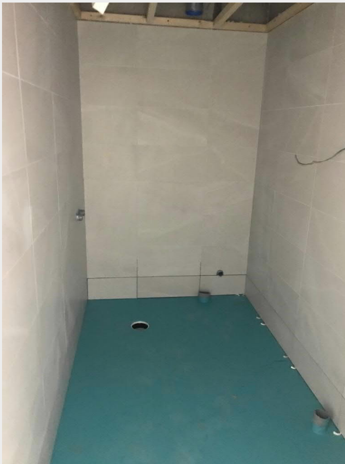
Märkätilan seinälaatoitus valmiina (kuva 19.6.2019).
