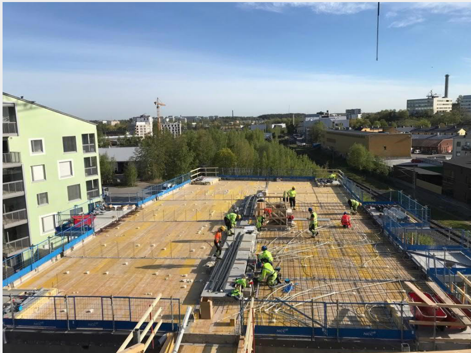
4. krs holvin raudoitustyöt ja tate-työt käynnissä.
