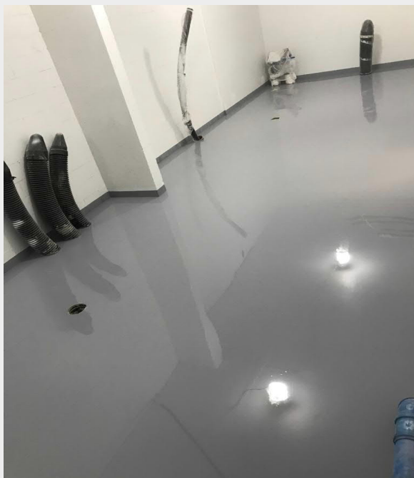
PU-lattiapinnoitus tehtynä L-talon tekniseen tilaan.
