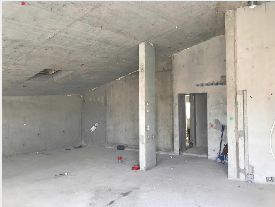
L-talon ullakkokerroksen betonipintaa.
