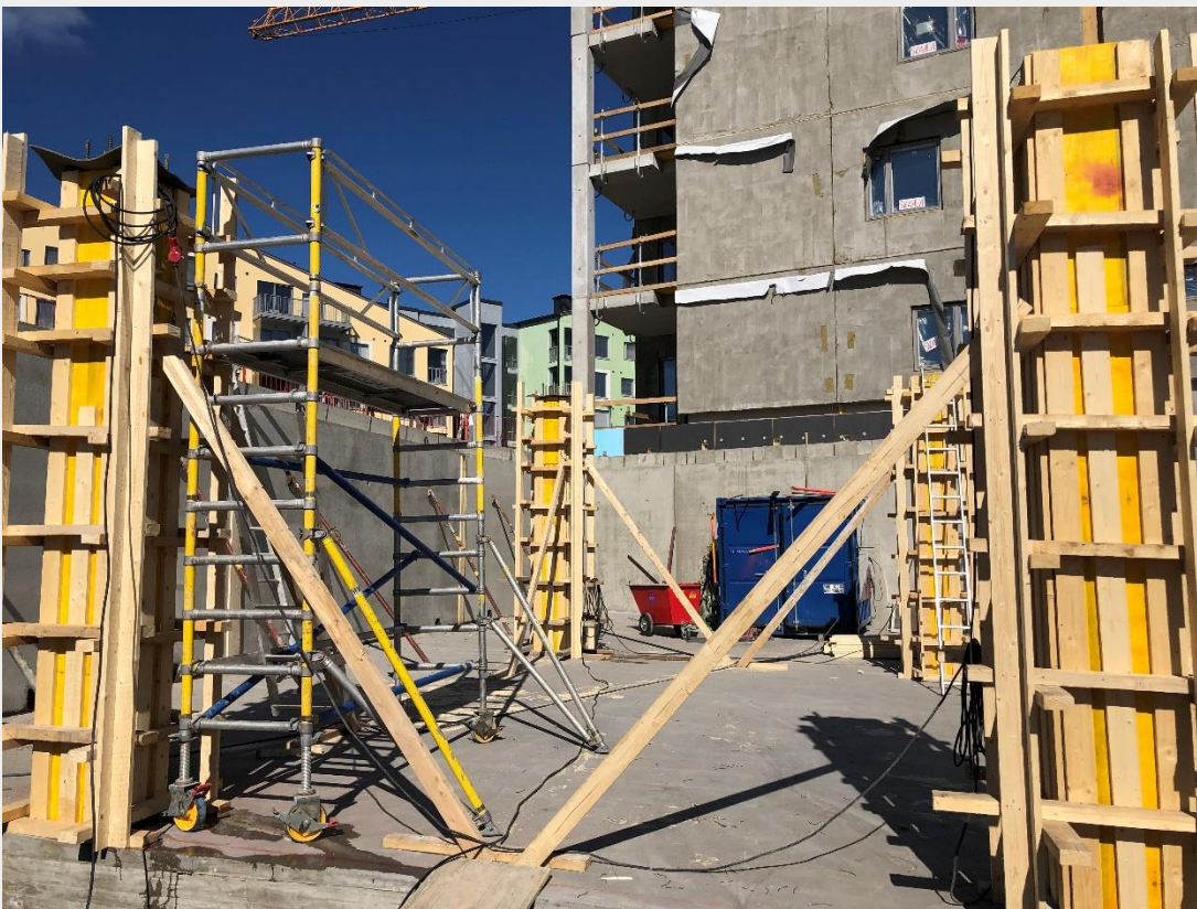
Jätekatoksen pilareiden valettu
