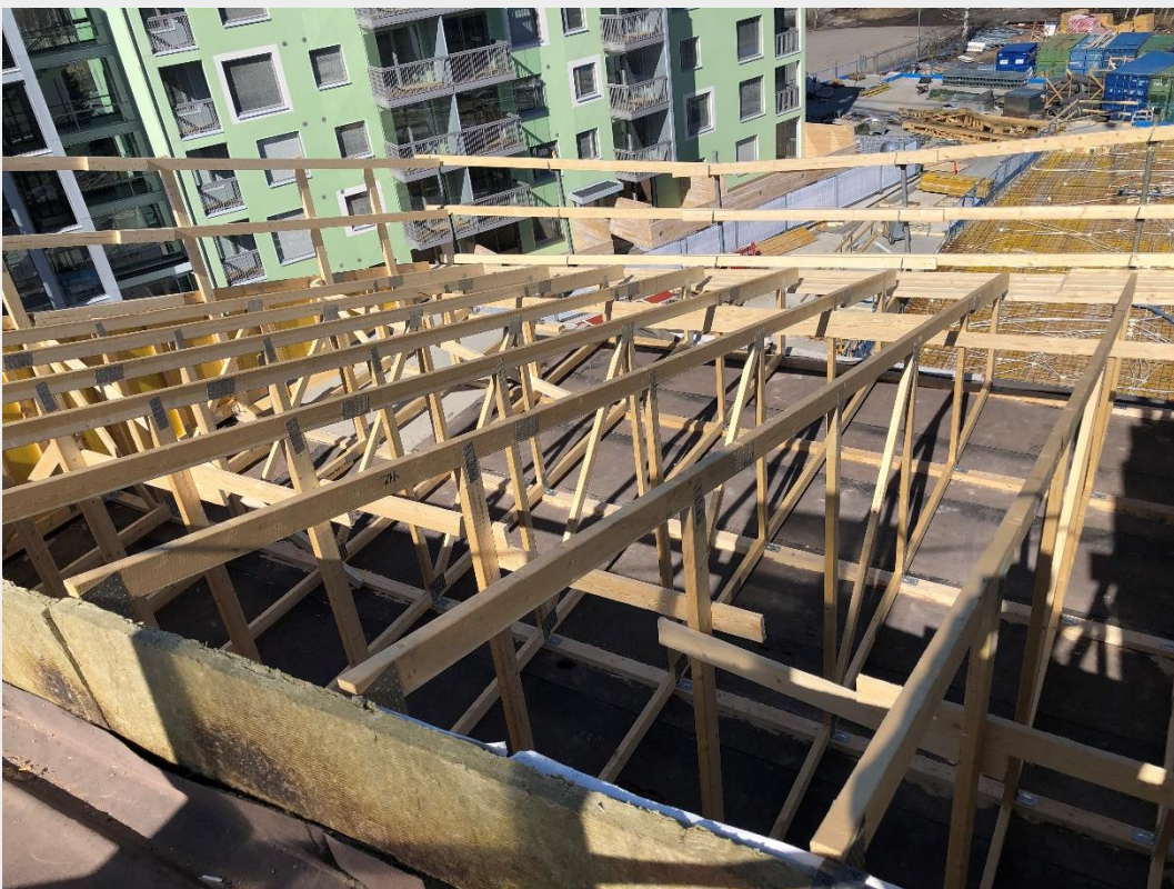
L-talon vesikaton kattopukkien asennus käynnissä
