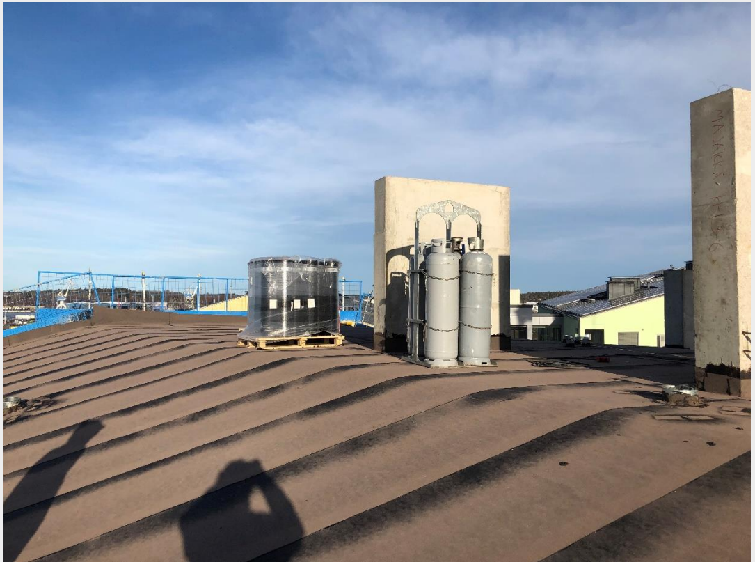
L-talon vesikaton höyrynsulkukermi asennettu
