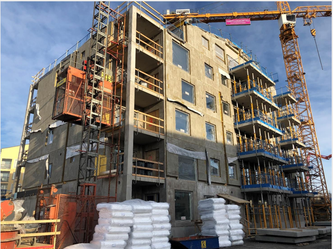
L-talon betonielementit asennettu ja vesikaton holvi valettu
