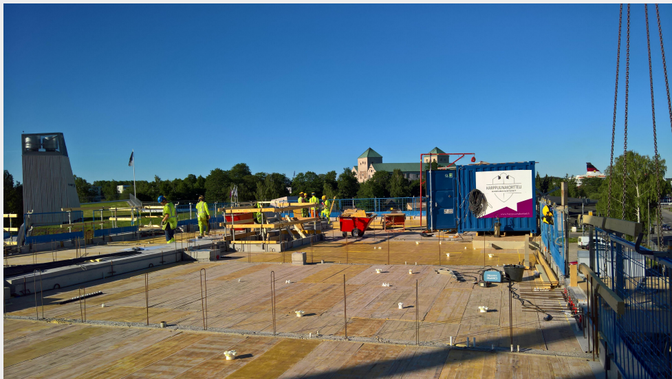
3. krs holvimuotti valmiina raudoituksia ja talotekniikka-asennuksia varten.
