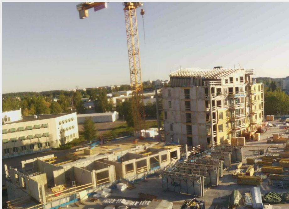
Yleisnäkymä työmaalle (työmaakamerakuva 21.5.2018).
