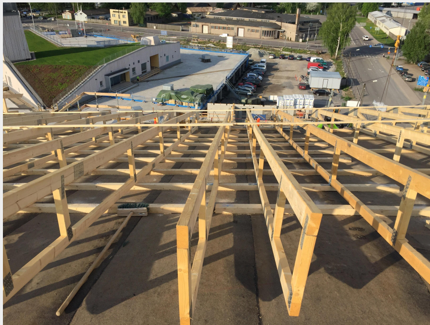
Kattotuolipukkeja asennettuna vesikatolla.
