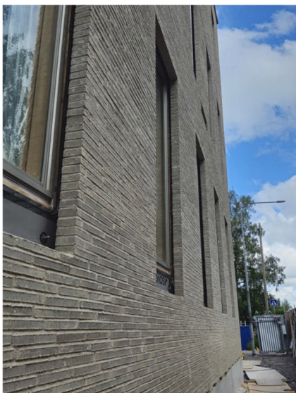
Kuva 2. Uusiosan muurattua julkisivua
