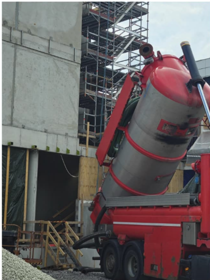
Kuva 1. Uudisosan alapohjan täyttötööt käynnissä
