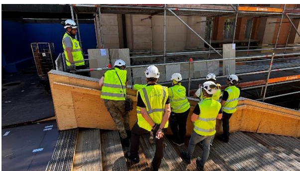
Kuva 6. Julkisivun maalausmallien katselmus.
