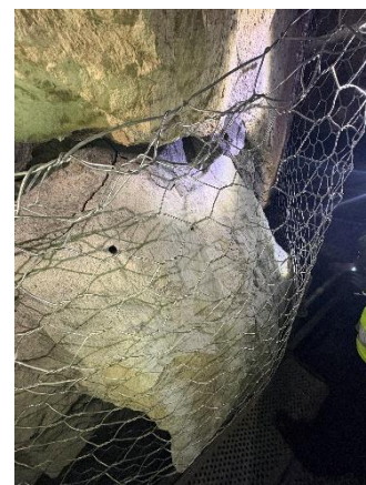
Kuva 2. Kallioseinän verkotusta.
