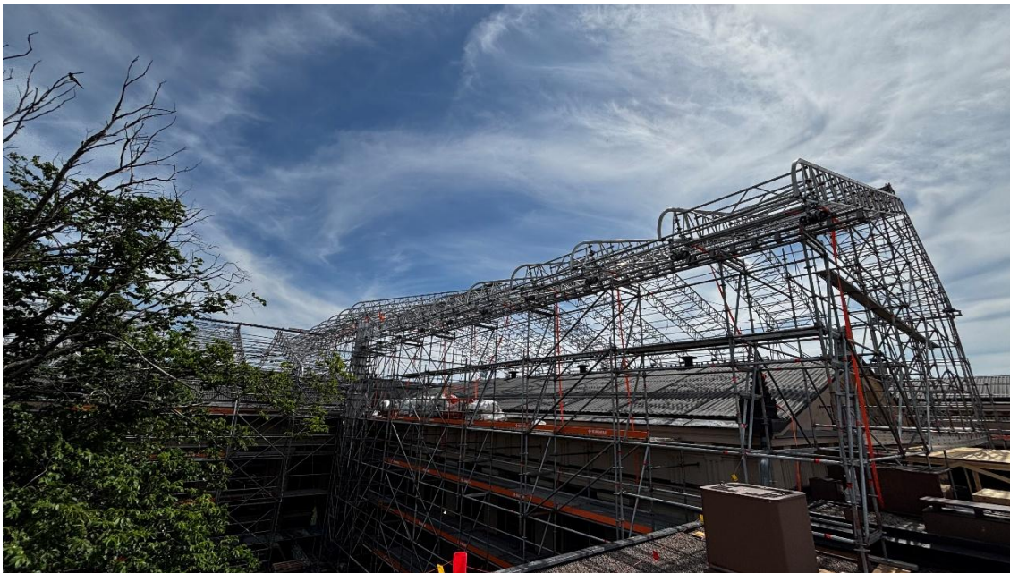
Kuva 5. Teline- ja sääsuoja-asennuksia.
