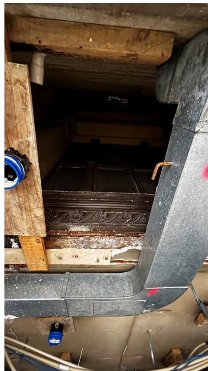
Kuva 8. Vanhat ikkunat rakennuksen laajennuksen kätköissä.
