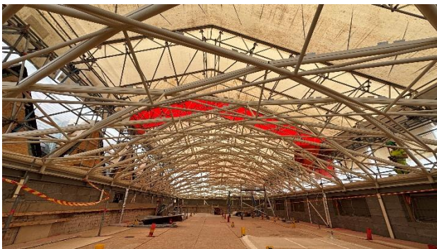
Kuva 3. Teräsrunko valmiina ennen lasien asennusta.
