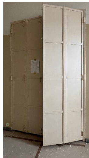
Kuva 9. Kunnostettu alkuperäinen rautataiteovi.
