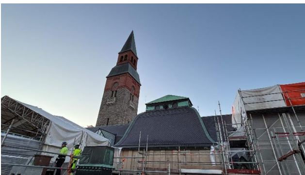
Kuva 1. Virastosiiven porrashuoneen liuskekivikatto ja uudelleen asennettuja kuparipellityksiä.
