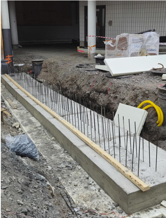
Kuva 1 ja 2. Autohallin luiskan tukimuurin pohjalaatta valettu ja tukimuurin muottiyöt käynnissä.
