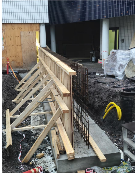
Kuva 1 ja 2. Autohallin luiskan tukimuurin pohjalaatta valettu ja tukimuurin muottiyöt käynnissä.
