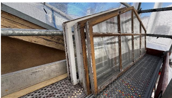
Kuva 5. Vaunuvajan ikkunoita lähdössä kunnostukseen.
