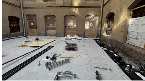
Kuva 8. Halkopihan korokelattiatyöt käynnissä.
