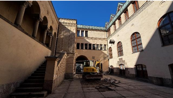
Kuva 9. Linnapihan kaivantotöiden aloitus.
