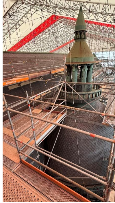
Kuva 7. 3. Lanterniinin kunnostus valmis.
