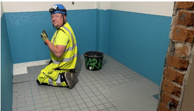
Kuva 4. Lattialaatoitusta pohjakerroksessa.
