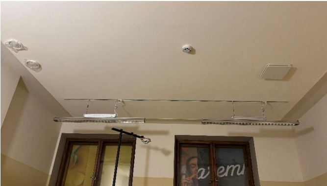
Kuva 1. Valaisin ja ilmanvaihtoventtiilien asennusta.
