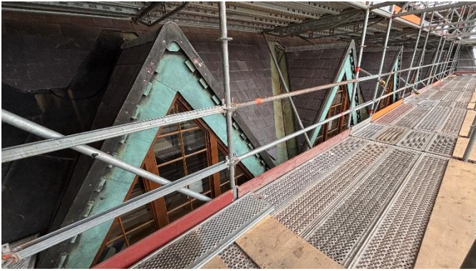
Kuva 8. Kattoikkunoita Kansantieteellisen osaston itäpuolella.
