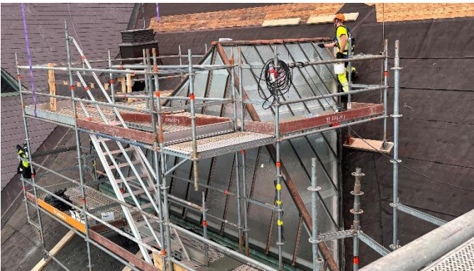
Kuva 6. Keskushallin Oculuksen lasikatteen kunnostusta.
