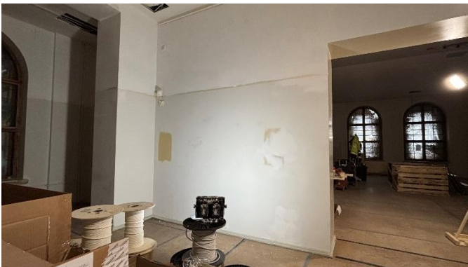
Kuva 2. Maalausten pohjatöitä 1. kerroksessa.
