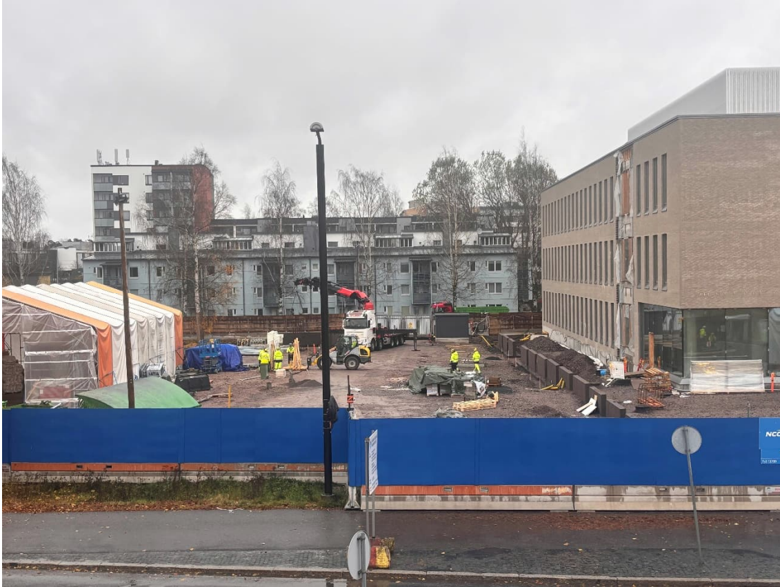
Kuva 1. Työmaahissi purettu laajennusosalta ja tukimuurien kivityöt käynnissä
