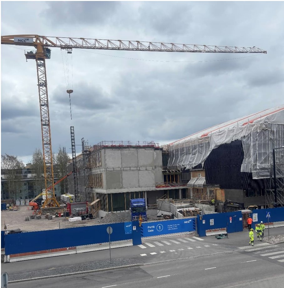
Kuva 1. Laajennusosalla julkisivun villoitukset käynnissä.
