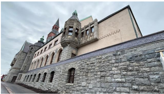
Kuva 8. Valmis julkisivu Mannerheimintielle.
