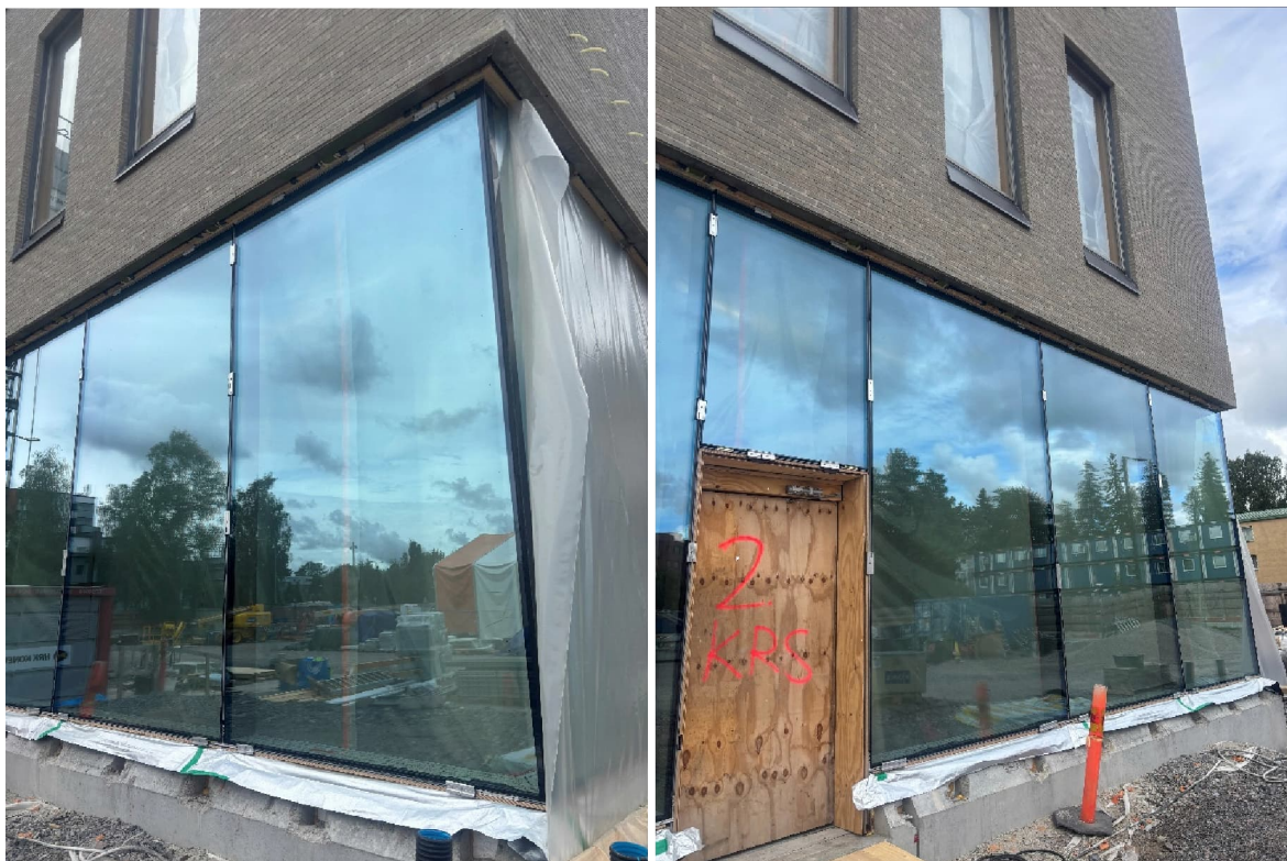
Kuva 1. Laajennusosan lasiseinän asennukset valmistuneet, korjausosan puoli vielä tekemättä.
