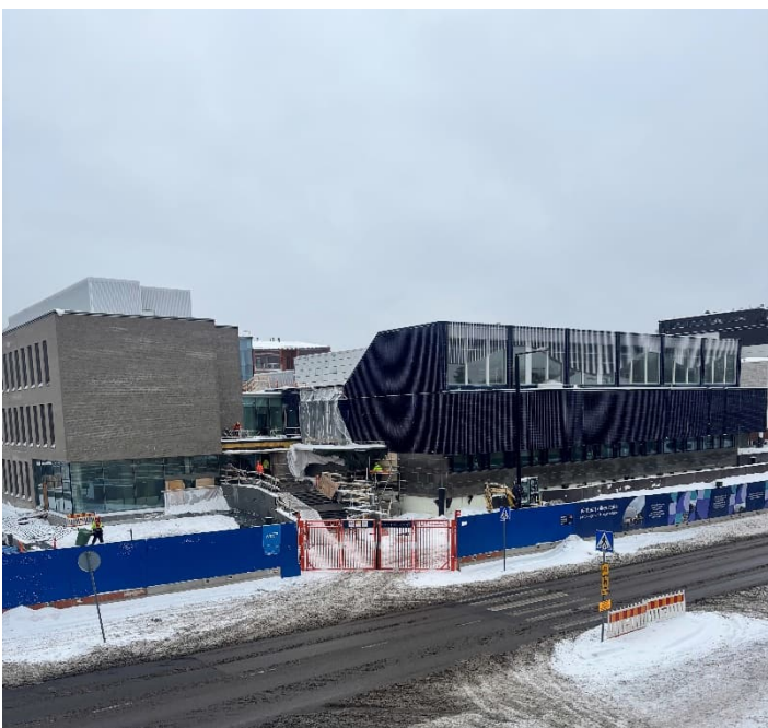
Kuva 1 ja 2. Piha- ja vihertyöt käynnissä Uudisosan piha-alueella.
