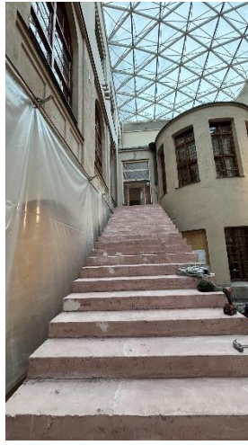
Kuva 2. Porras muotin purun jälkeen.
