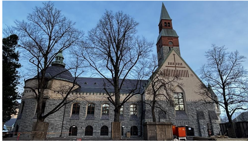
Kuva 7. Julkisivu etelään, työmaaparakkien purun jälkeen.
