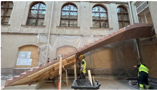
Kuva 4. Portaan muotin purkua.
