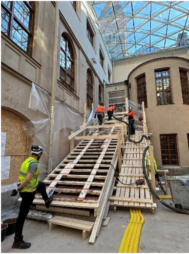
Kuva 1. Betoniportaan valu.
