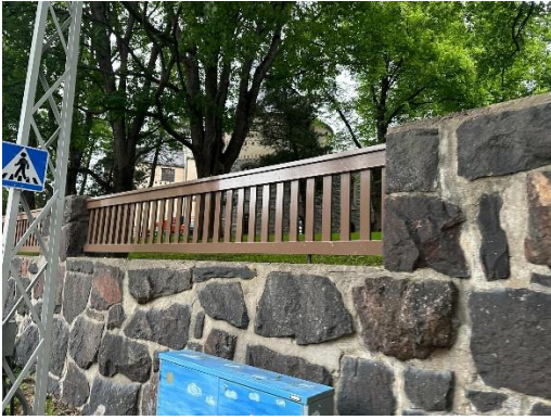
Kuva 1. Eteläpihan aidat asennettuna
