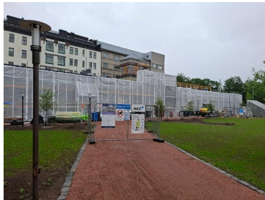
Kuva 4. Vaunuvajan telineet on asennettu
