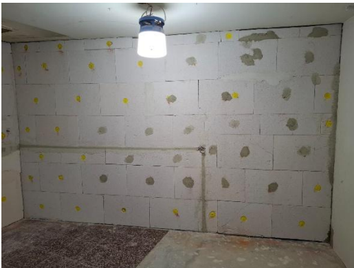
Kuva 3. Asennettuja silikaattilevyjä
