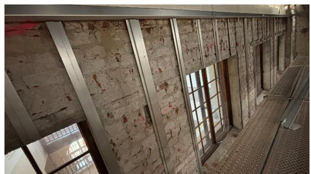
Kuva 2. Halkopihan seinien akustolevytysten pohjia.
