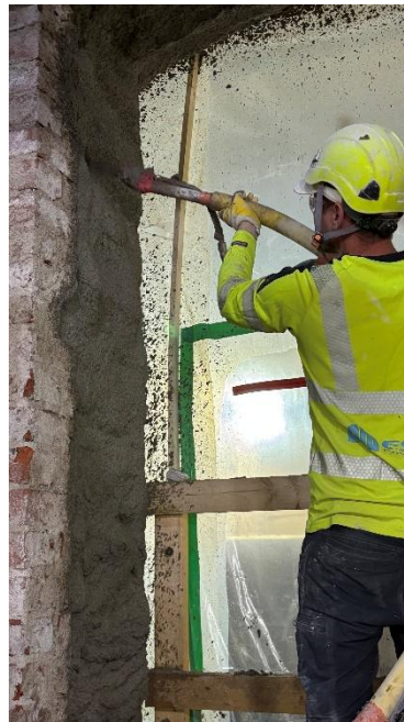
Kuva 4. Pohjarappausa Atlas rajapinnassa.
