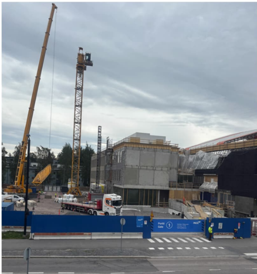
Kuva 1. Torninosturi purettu
