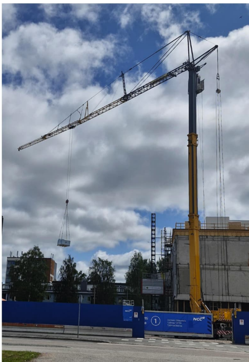
Kuva 2. IV-koneiden nostoja
