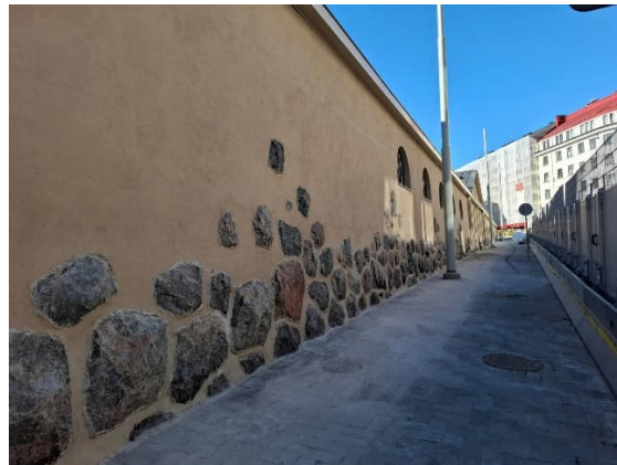
Kuva 4. Cygnaeuksenkadun telineet on purettu
