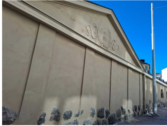
Kuva 2. Keskirisaliitin kunnostettuna Cygnaeuksenkadun puolella
