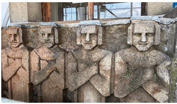
Kuva 3. Vuolukivikonservointi käynnissä Mannerheimintien parvekkeen ulkopinnan reliefissä. Vasemmalla puhdistettua kuviota ja oikealla sammaloitunutta, puhdistamattomaa kuvio.
