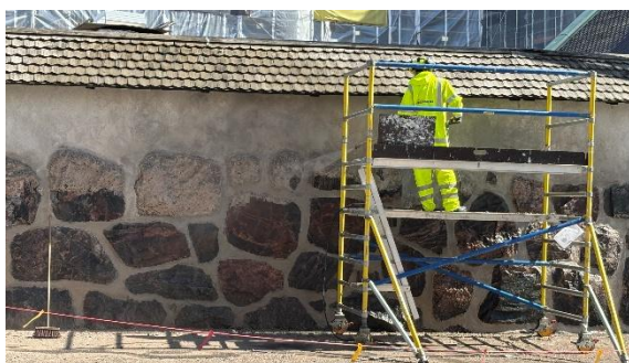
Kuva 6. Muurikivien pesua rappauslaastista.
