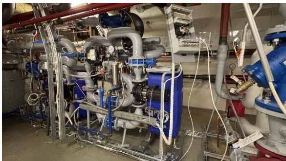
Kuva 8. Uusi lämmönjakolaitteisto.
