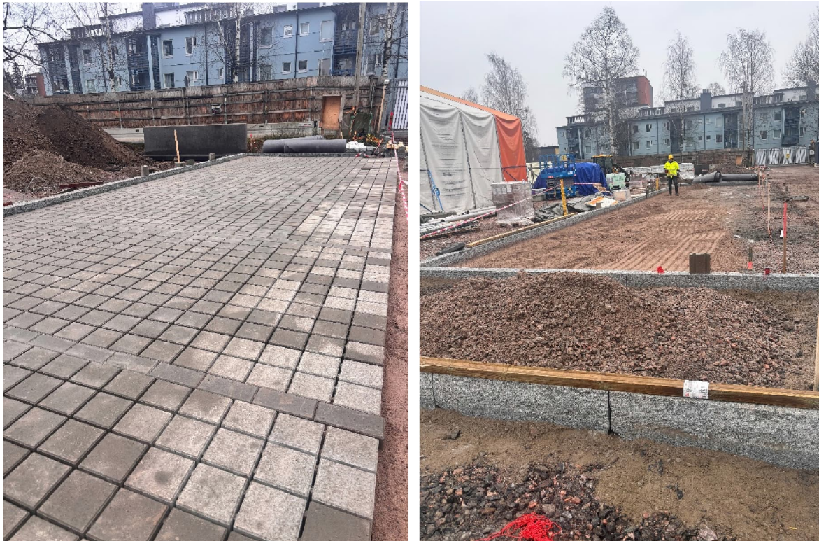
Kuvat 1–2. Piha- ja kivityöt edistyvät ripeästi ennen talven tuloa.
