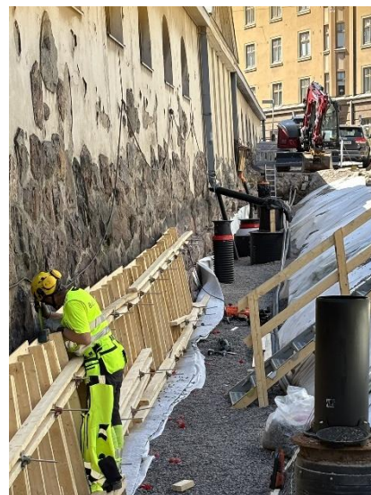
Kuva 5. Aitamuurista löytyi onttoja kohtia, vaikka se on pääosin muurattu umpeen.
