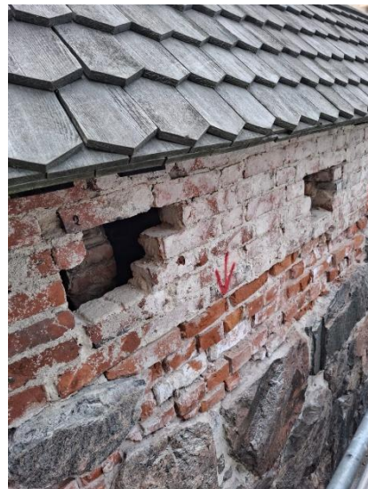
Kuva 5. Aitamuurista löytyi onttoja kohtia, vaikka se on pääosin muurattu umpeen.
