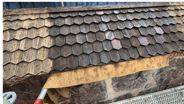
Kuva 3. Paanukatteen tervausmalli.
