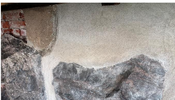
Kuva 6. Aitamuurin rappausmalli.
