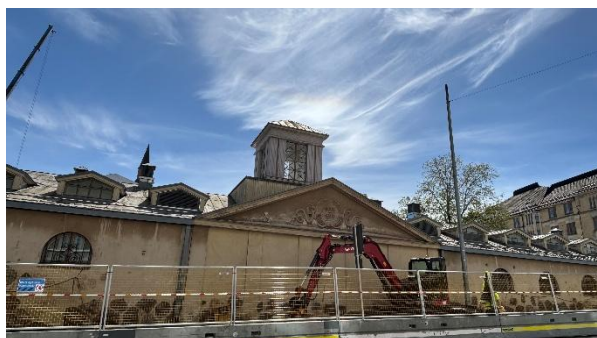
Kuva 7 ja 8. Vaunuvaajan ympäristössä tehdään kaivuutöitä salaojituksia ja asennusreittejä varten. Työt ovatkin jo hyvässä vauhdissa Cygnauksenkadulla.
